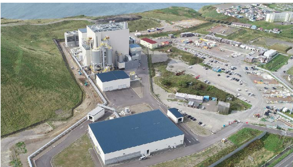
釧路コールマインの石炭を使用した釧路火力発電所
